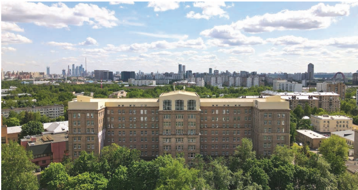
Главный корпус ФМБЦ им. А.И. Бурназяна.
