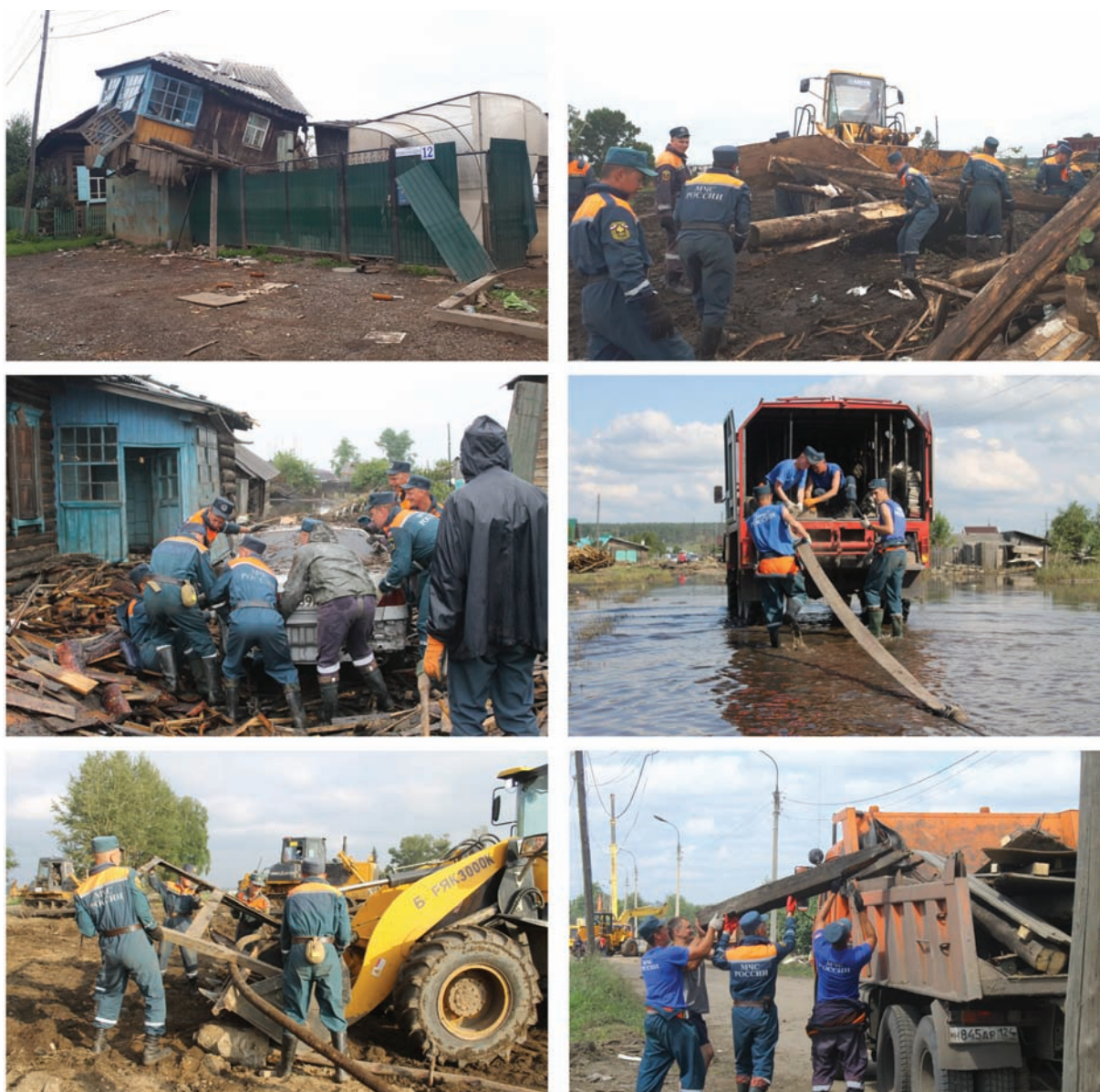
Рис. 3. Выполнение аварийно-восстановительных работ в г. Тулуе Иркутской области.
